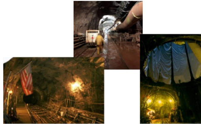
Ejemplo de las tareas de perforación del túnel
